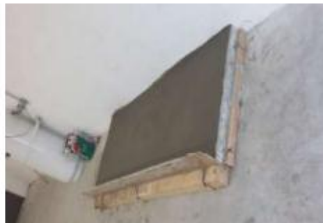
Fabricación de bases de concreto donde se montará transformador y banco de capacitore.
